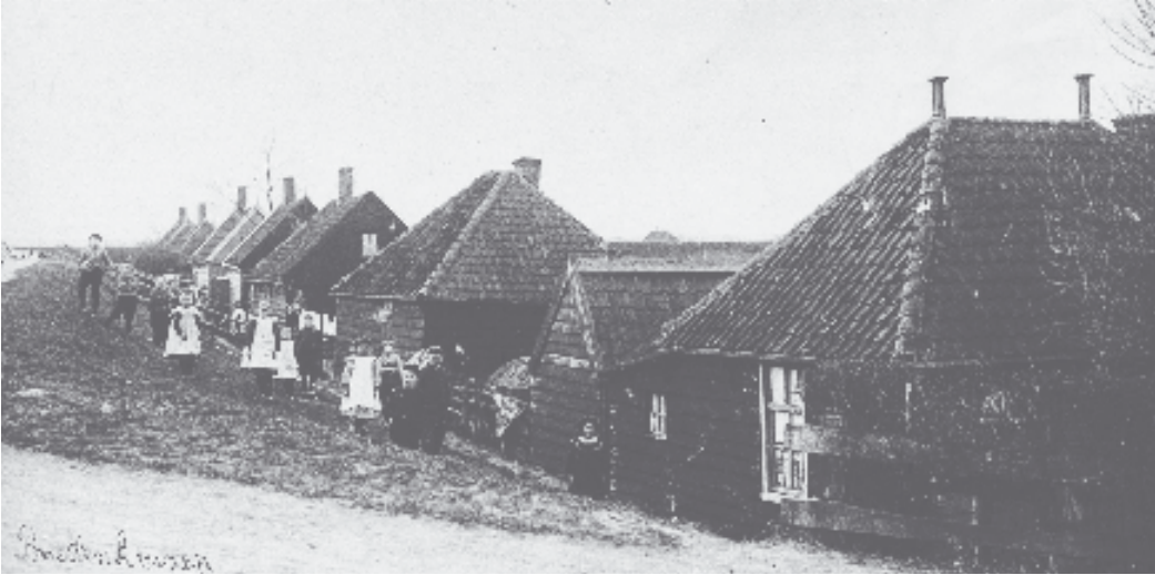
Woonomstandigheden onderaan de dijk bij Buitenhuizen (GAZ).
