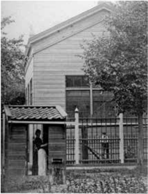
Het Czaar Peterhuisje in 1872, verscholen in de nieuwe houten overkapping. Het hokje links was vermoedelijk de ingang waar de toegangskaartjes werden verkocht (foto GAZ, collectie Breebaart).
