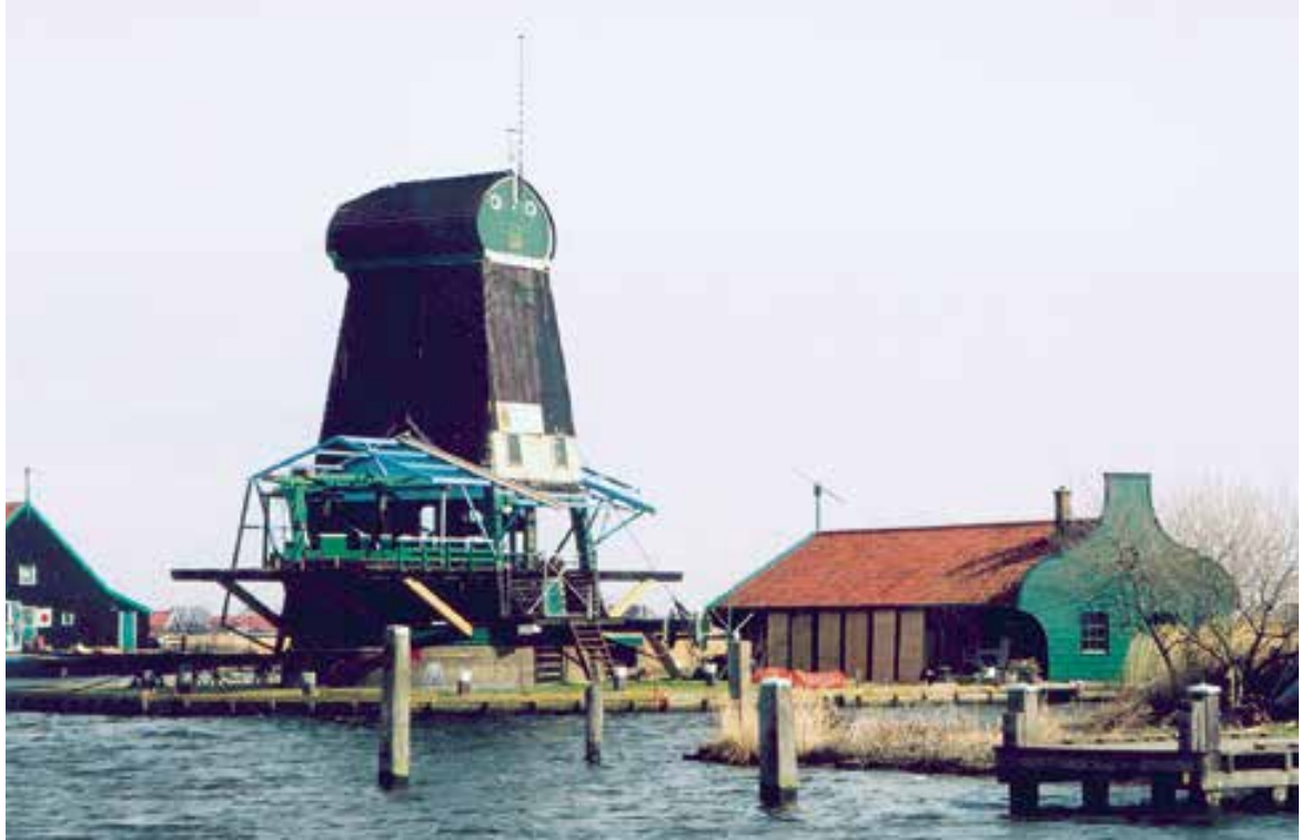
De gekroonde Poelenburg' tijdens de restauratie – voorjaar 2005.
